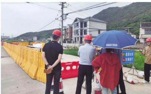
本次检查聚焦节日期间安全风险突出的重点环节。检查组首先来到城镇排水管网改造项目现场,针对国庆期间人车流量大的特点,重点检查了围挡设置、交通导行和警示标识等情况,要求确保施工区与公共区域有效隔离,最大限度减少对市民出行的影响。同时,强调要加强沟槽、基坑等临边防护的巡查维护,及时消除安全隐患,坚决防范事故发生。
