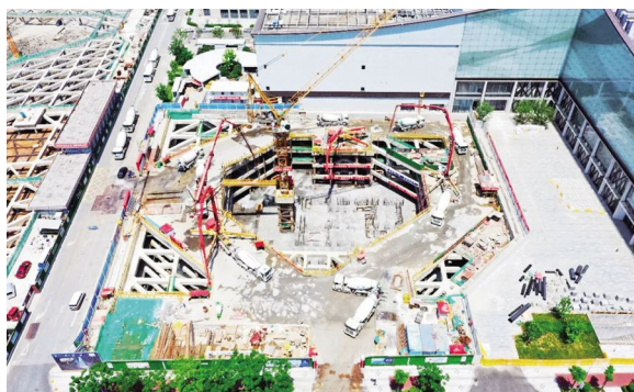
超厚基础底板高性能混凝土一次性浇筑
